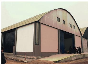
Este proyecto se enmarca en el Programa de Asistencia Financiera No Reembolsable para Proyectos de Japón (APC) y la construcción comprende la cimentación con zapatas y muros de concreto armado, vigas y perfiles metálicos, cobertura liviana de planchas de fibrocemento (eternit), y sus respectivas instalaciones eléctricas. La donación incluyó la dotación de anaqueles adecuados, dentro del mismo almacén, para permitir la fácil ubicación de los equipos y materiales a ser despachados.
